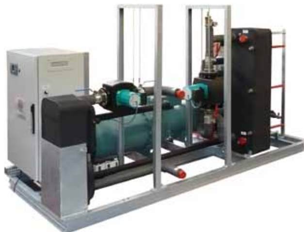
Центральный энергоблок Titan Z (На примере модели Titan Z 230 WWHT)
